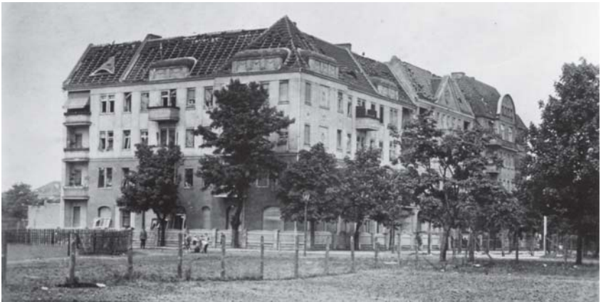
Ein durch die Explosion beschädigtes Haus in der Otto-Franke-Straße
